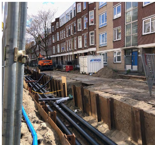
Voorbeeld van aanleg warmtenet.
