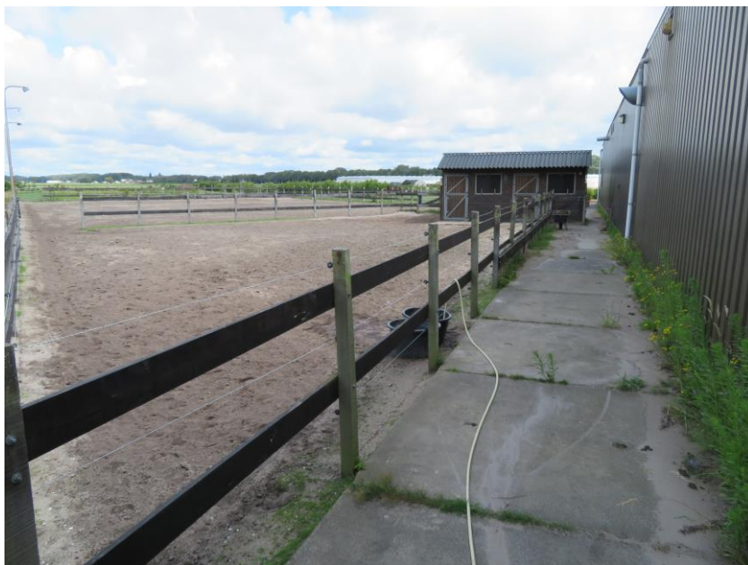
Figuur 4: Te slopen loods (rechts) en de stal waarin voorzieningen voor boerenwaluw worden genomen. In het verleden heeft boerenwaluw in de stal gebreed.
