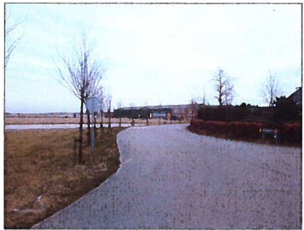
Sierkersen langs toegangsweg
